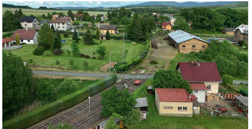
Pohled na obnovený souběh úzkorozchodné tratě před Děřichovem. Za přejezdem se po pravé straně nacházelo skladiště firmy TOTEX (dříve firma C.A.Preibisch), ke kterému vedla 83 m dlouhá vlečková kolej. Z vlečky se zboží překládalo na průmyslovou drážku o rozchodu 600 mm, která je rozvážela po areálu továrny. Oranžová budova v pozadí je původní staniční budova Děřichov. FOTO: MICHAL ROH
