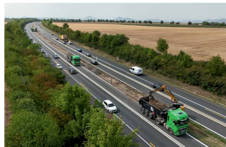
Stavební práce na D8 – nákladní automobily firmy Štochl Group odvázejí vytěženou zeminu z dělicího pruhu do lovosického přístavu.
