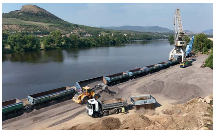
V přístavu v Lovosicích probíhá vykládka kameniva a jeho překládka na nákladní automobily. Zároveň je zde do železničních vozů nakládána vytěžená hlína z dělicího pruhu.
