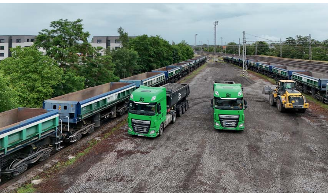
Do jednoho železničního vozu se vejde cca 25 tun kameniva, tzn. přibližně objem jednoho kamionu.
