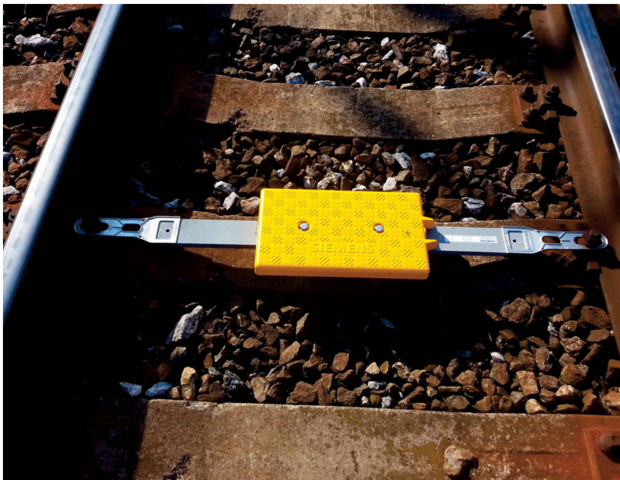
Balíza na trati SŽDC. Tak jako je stavba podpěr budoucího trakčního vedení signálem budoucí elektrizace trati, je osazování balíz předvojem aplikace systému ETCS. Svým charakteristickým tvarem a zbarvením dávají balízy zřetelnou informaci o tom, jak na české železnici postupuje budování nového moderního vlakového zabezpečovače.
