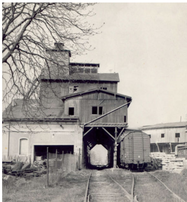
Nakládka kaolinu na vlečce hlubinného dolu Excelsior v roce 1967 (foto Pavel Chvostal)
