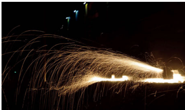
Noční broušení kolejnic je velmi působivé (traťový úsek Rudoltice v Čechách – Třebovice v Čechách)
