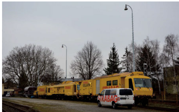
Příprava broušící frézy před výkonem ve stanici Studénka
