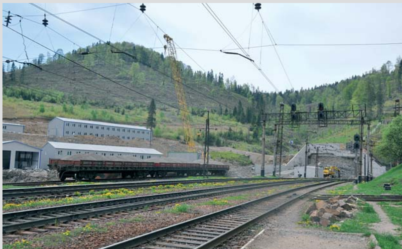
Stavba nového portálu u stanice Beskid
