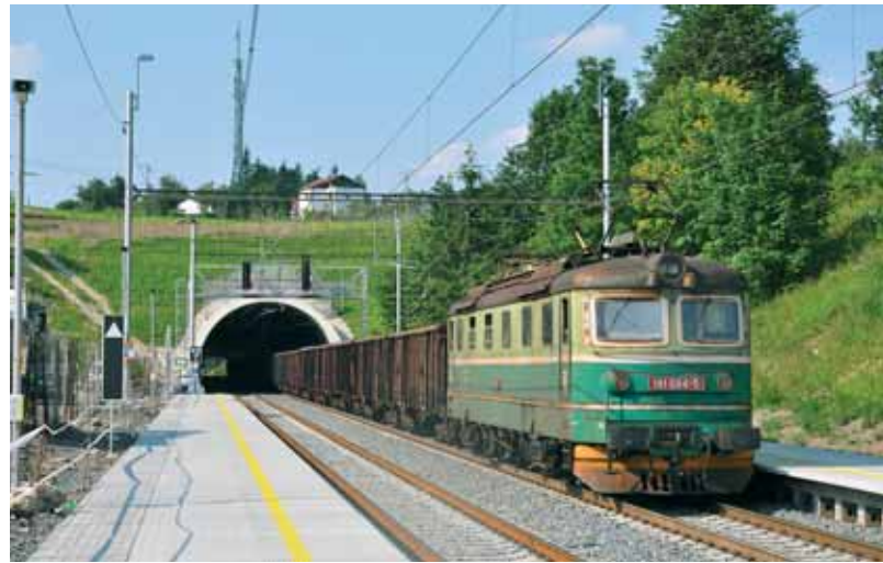
„Šestikola“ 181.084 na postrku rudného vlaku z Čadce do Třince vjíždí do nového tunelu u Mostů u Jablunkova. Foto: Michal Roh
