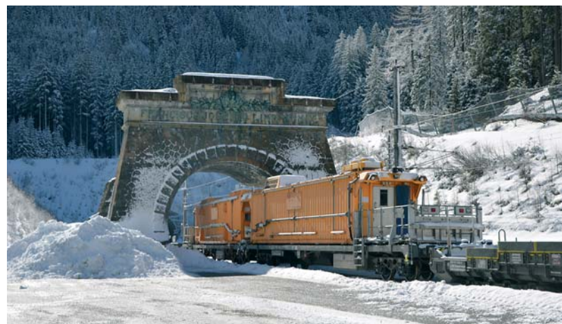
... a stav v březnu 2018. Na koleji v tunelu je odstaven speciální záchranářský vlak.
