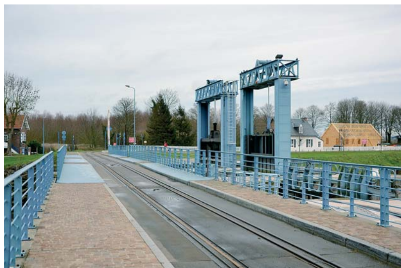
Kombinovaný silničně-železniční most přes Sommský kanál v Saint-Valery-sur-Somme
