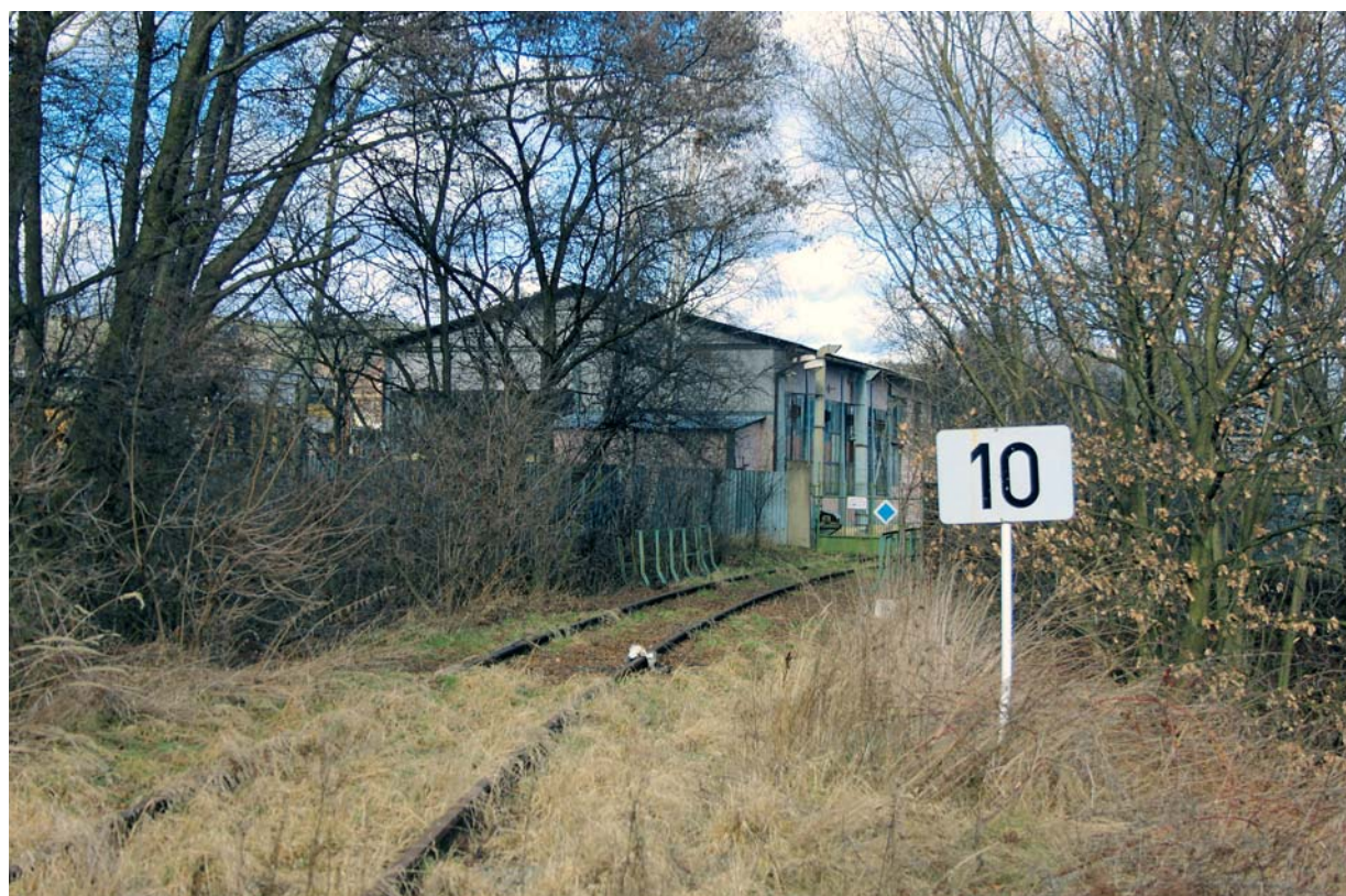
Vjezd do areálu Kovohutí – stav v únoru 2014
