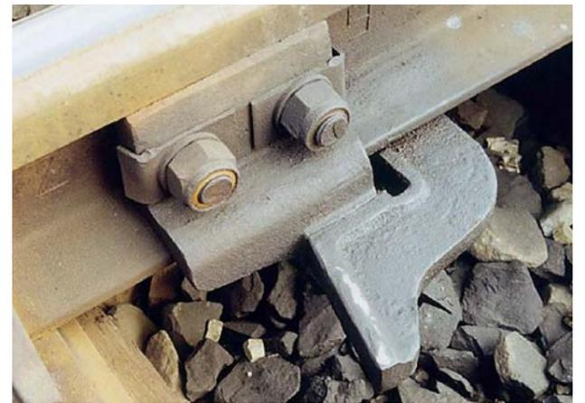
Bei einer zungenverriegelnden Weiche muss der Haken der anliegenden Zunge der Weiche durch ein Verriegelungslineal so unterstützt werden, dass die Kante der Verriegelungsfläche des Verriegelungslineals mit der Kante des Kopfes des Verriegelungshakens überlappt oder flucht.
