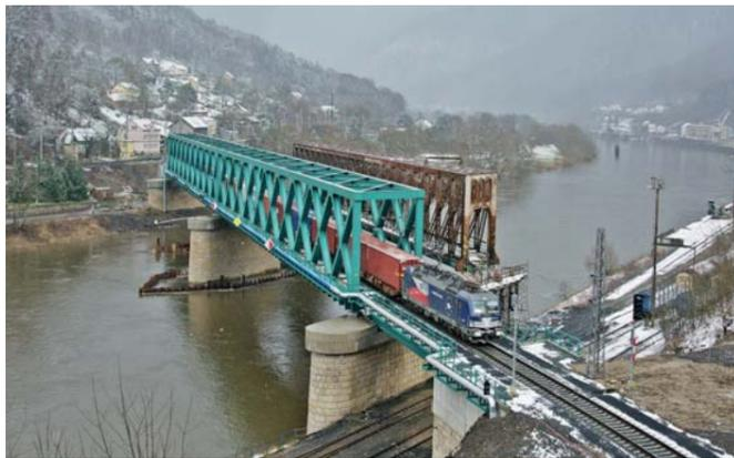
Eine moderne ČD Cargo-Lok 383.001 mit dem Container Nex 44387 fährt über die neue Eisenbahnbrücke. Das alte Bauwerk, das zur Seite geschoben wurde, wird nach und nach abgebaut und zur Entsorgung abtransportiert.
