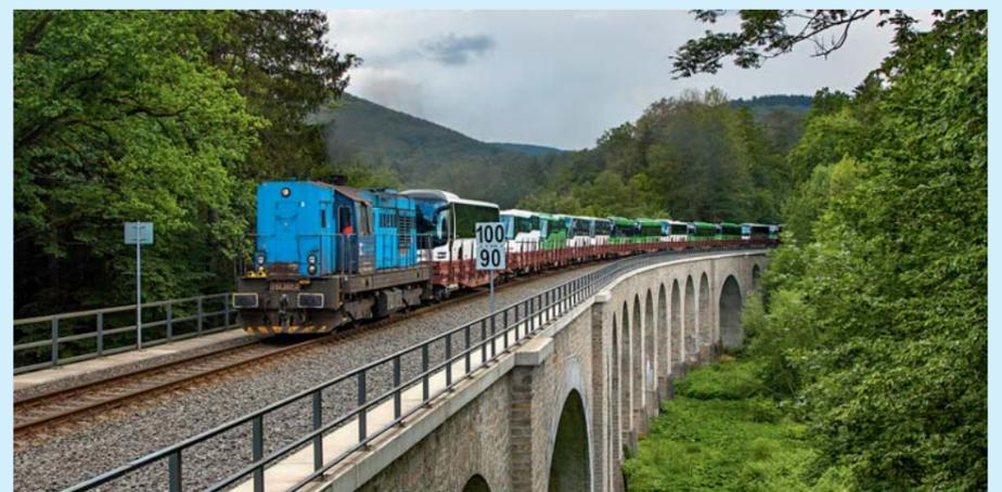
Lokomotive 742.369 an der Spitze des Umschlagzugs Mn 84041, dessen Ladung am 31. Mai 2024 aus 12 mit Wagen beladenen Triebwagen bestand. Das Bild wurde auf dem 238 Meter langen Machnin-Viadukt aufgenommen, der als Doppelgleis gebaut wurde, aber die Verlegung des zweiten Gleises fand nie statt. FOTO: TOMÁŠ SLUKA
