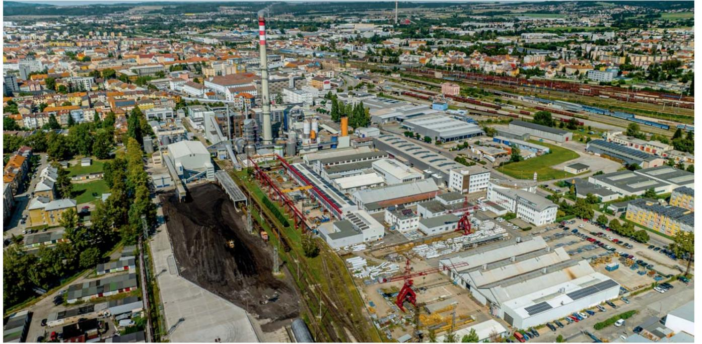
Luftaufnahme des Heizwerks in České Budějovice. Im Tieflager wird gerade Kohle aus den Eisenbahnwaggons entladen. Im Hintergrund ist der Schornstein des Heizwerks Vráto zu sehen. FOTO: TCB
