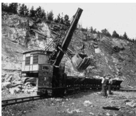
Nakládka vytěžené suroviny do vozíků úzkorozchodné dráhy v Solvayových lomech. Lokomotiva č. 3 s benzino-elektrickým přenosem výkonu vyrobená v Královopolské v Brně pracovala v lomu od roku 1931 cca do roku 1950.
