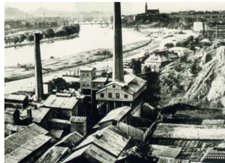
Pohled na cementárnu v Praze-Podolí na přelomu století. FOTO: SBÍRKA MICHAL ROH
