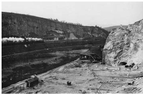
Lom Alkazar u Srbska. Na snímku můžeme spatřit jak rozvětvení úzkorozchodné dráhy, tak lanovou dráhu systému Bleichert vedoucí k překladišti na druhém břehu řeky Berounky.
