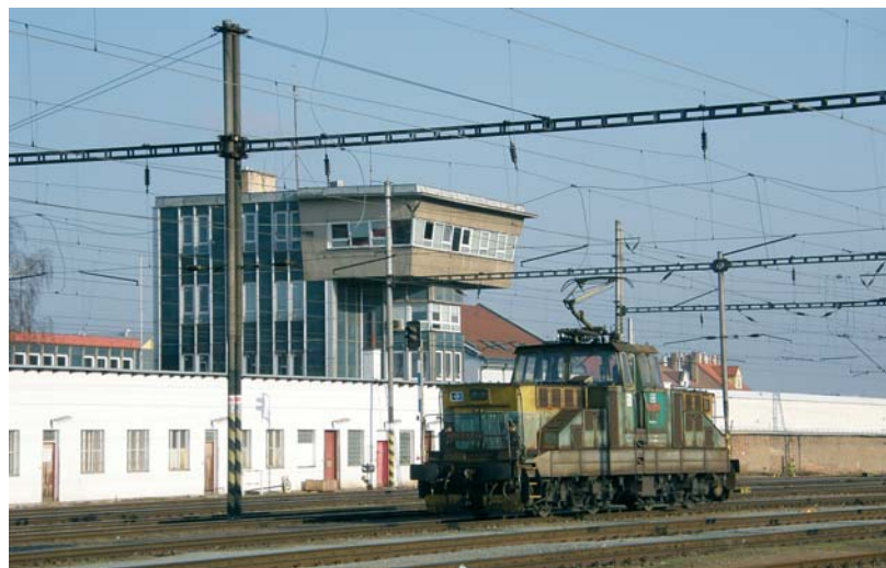
V rámci protikrizových opatření musela být optimalizována činnost v seřadovacích stanicích. Praha-Libeň
