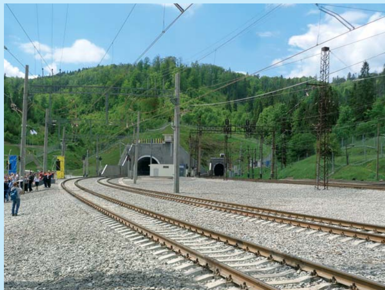
Pohled na nový a starý portál tunelu Beskidy ve východních Karpatech
