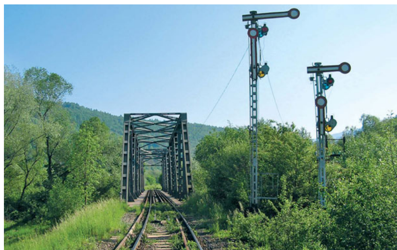
Čtyřkolejnicová splítka na rumunském území je dnes využívána pouze vlaky normálního rozchodu. Návěstidlo vpravo je platné pro široký rozchod, návěstidlo vlevo pro normální. Valea Vișeuului – květen 2007.
