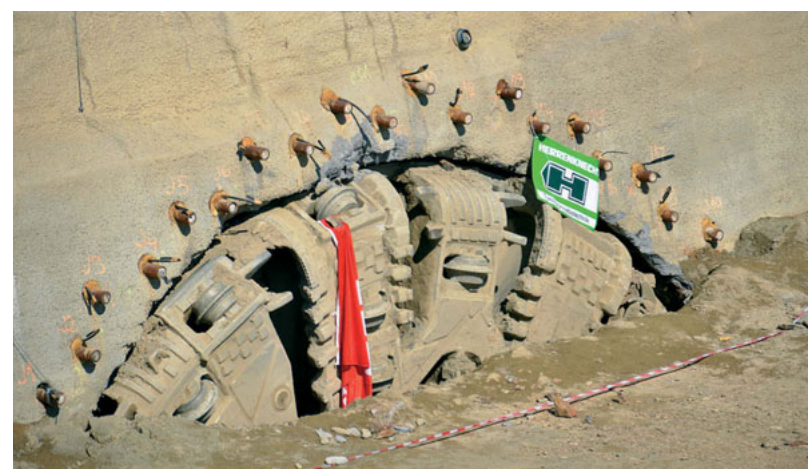
7. června letošního roku došlo v plzeňské čtvrti Doubravka k proražení vrchní části portálu jižní trouby více než čtyřkilometrové tunelu Ejpovice. Stalo se tak po téměř roce a půl ražby. Slavnostní okamžik zachytil svým fotoaparátem zaměstnanec PP Plzeň pan Libor Lorenc . Dodejme, že tunel Ejpovice se nachází na modernizovaném úseku tranzitního koridoru mezi Plzní a Rokycany.
