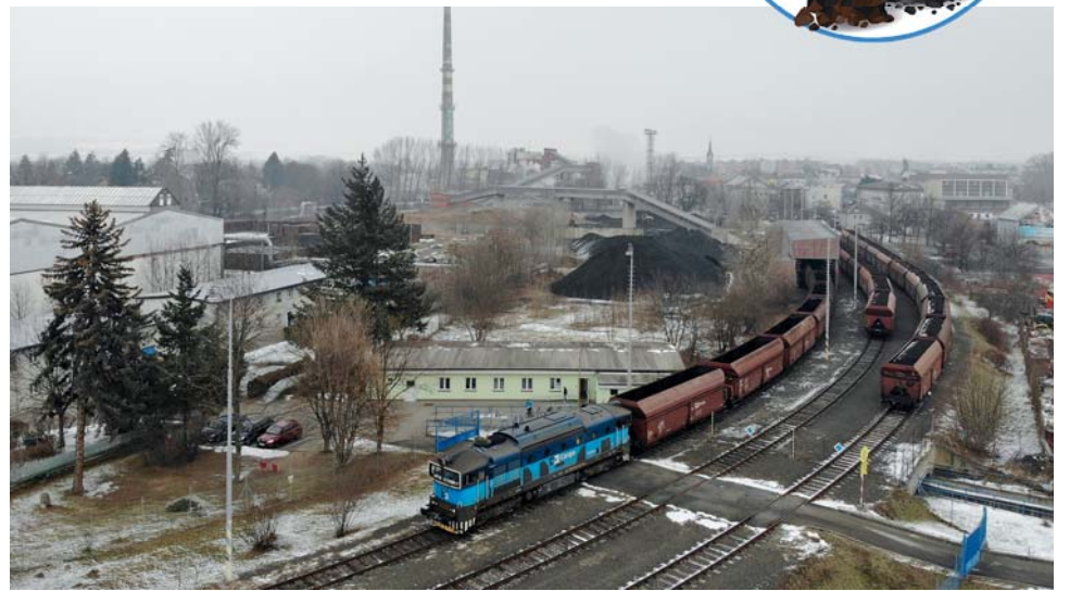
Celkový pohled na areál krnovské teplárny
