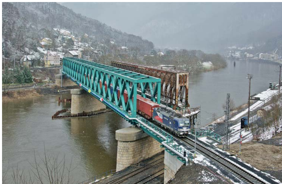
Po novém železničním mostě projíždí moderní stroj 383.001 ČD Cargo s kontejnerovým Nex 44387. Vedle odsunutá stará konstrukce se postupně rozebírá a odváží na likvidaci.
