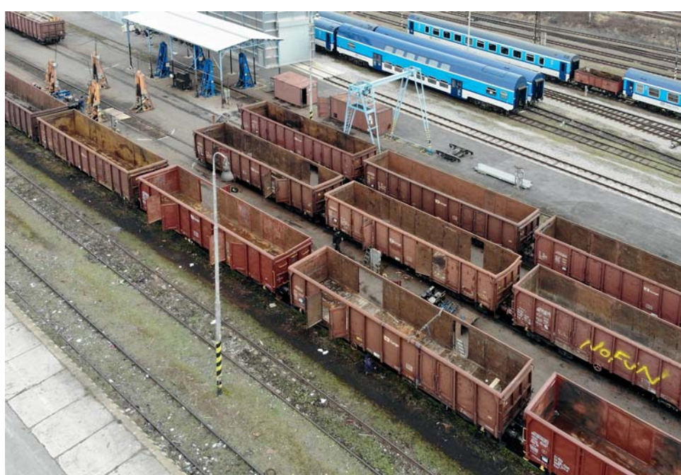
Nevyhovující venkovní areál, ve kterém jsou v současné době v Českých Budějovicích prováděny opravy nákladních vozů.
