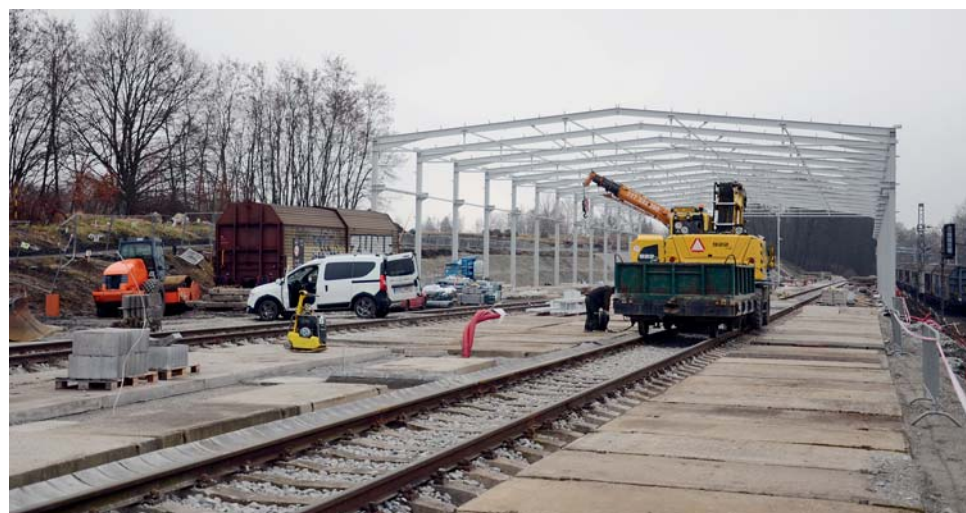
Výstavbu kolejiště v nové opravně provádí společnost FIRESTA-Fišer, rekonstrukce, stavby.
